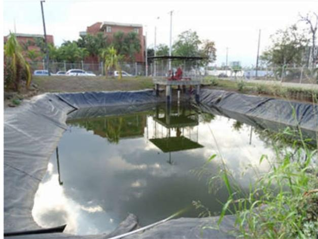
Figura 7. Reservorio de agua lluvia utilizada para el riego de jardines y ante la eventualidad de un incendio
