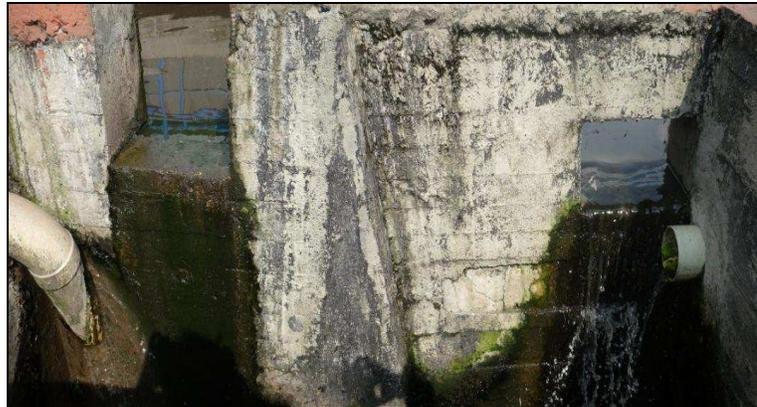
Foto N° 12 – Cámara de Flotante con reboses del Tanque de Aireación y Tanque Sedimentador
