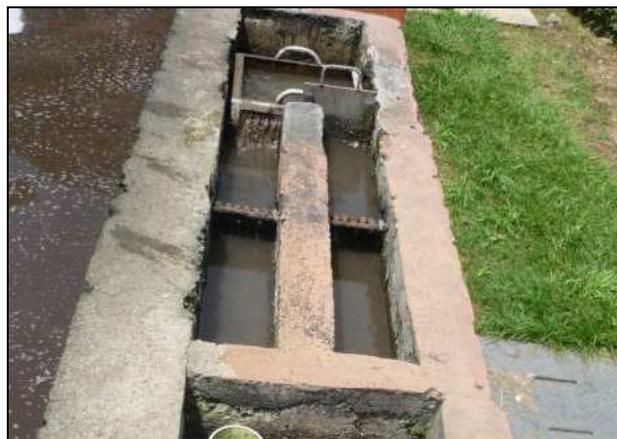
Foto N° 4. Desarenadores del Canal de Llegada
