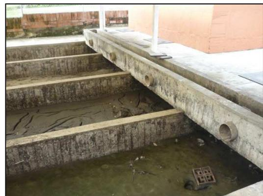
Foto N° 23 y N° 24 – Aspecto de los lechos de secado que actualmente funcionan
