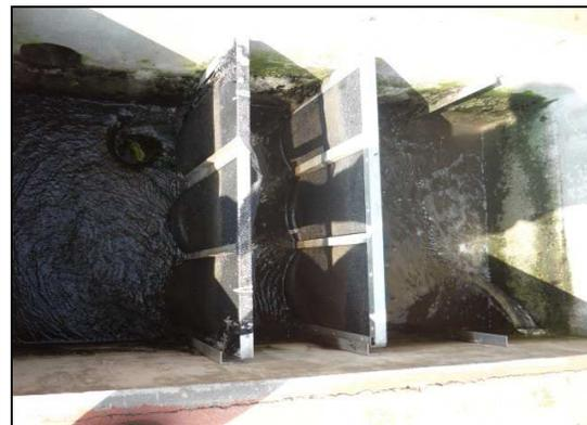
Foto N° 13 y 14 – Cámara Tamiz para retención de Sólidos
