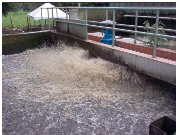
Foto N° 6 – Tanque de Aireación
