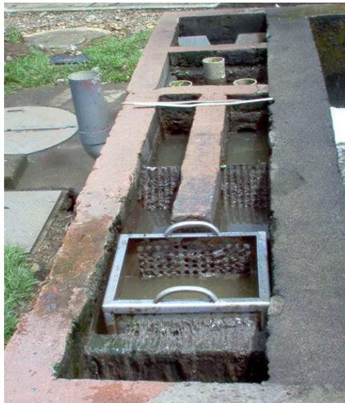
Foto N° 3. Se aprecia el canal de llegada el Sistema. En su Orden de Abajo hacia Arriba la canastilla de Sólidos, Los dos desarenadores, la Trampa de Grasas y por último el vertedero.
