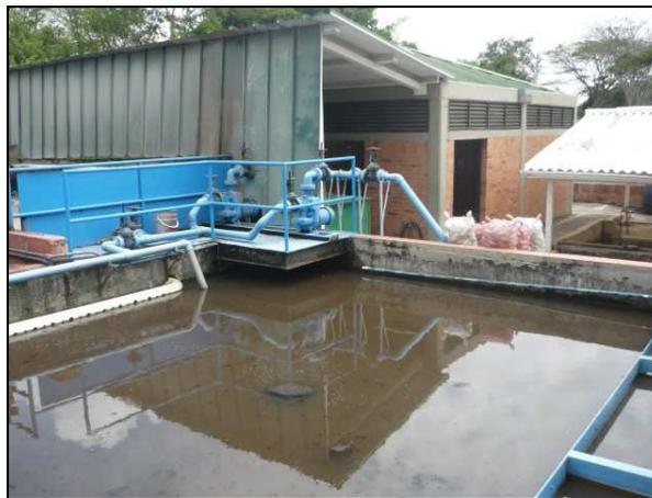
Foto N° 9 – Sistema de Bombas para Recirculación hacia tanque de Aireación
