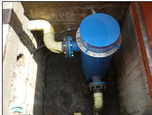
Foto N° 17 y 18 – Montaje de la Unidad de Desinfección LUV (Luz Ultravioleta)
