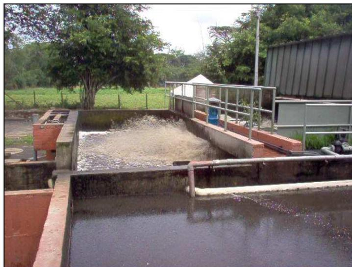
Foto N° 11 – Conjunto Tanque de Aireación y Tanque Sedimentador
