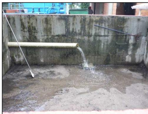
Foto N° 15 y 16 – Unidad de Filtración con Lecho de Arena
