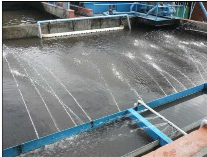
Foto N° 10 – Sistema de Aspersión en el Tanque Sedimentador
