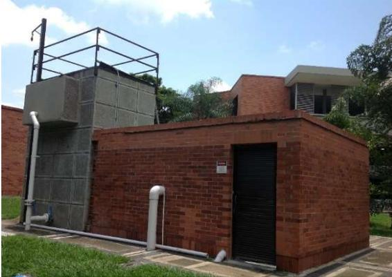
**Reservorio de aguas lluvias e infiltración**
