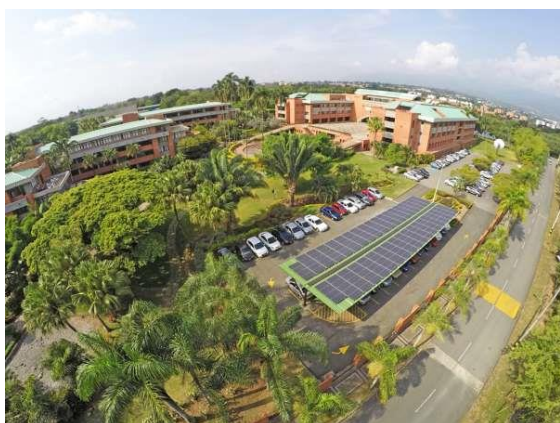
Figura 3. Sistema Solar Fotovoltaico y central hidroeléctrica
